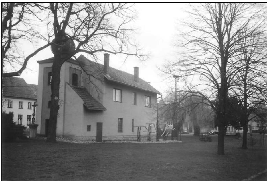
Obr. č. 16: B. Málkovice - Obecní úřad a nefunkční kaple i hasičská zbrojnice
