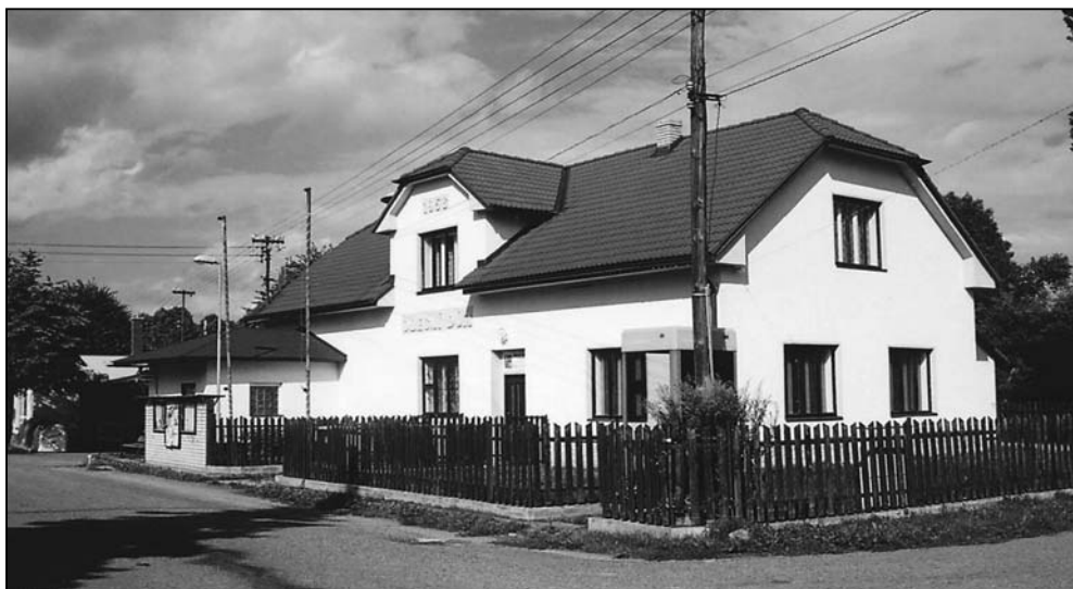
Obr. č. 7: Budova obecního úřadu a hasičské zbrojnice (Otradov)
