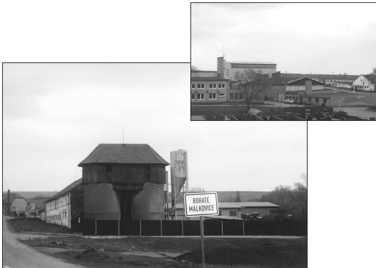
Obr. č. 6, 7: B. Málkovice - Sýpka, areál bývalého JZD, nyní společnost ZEMO
