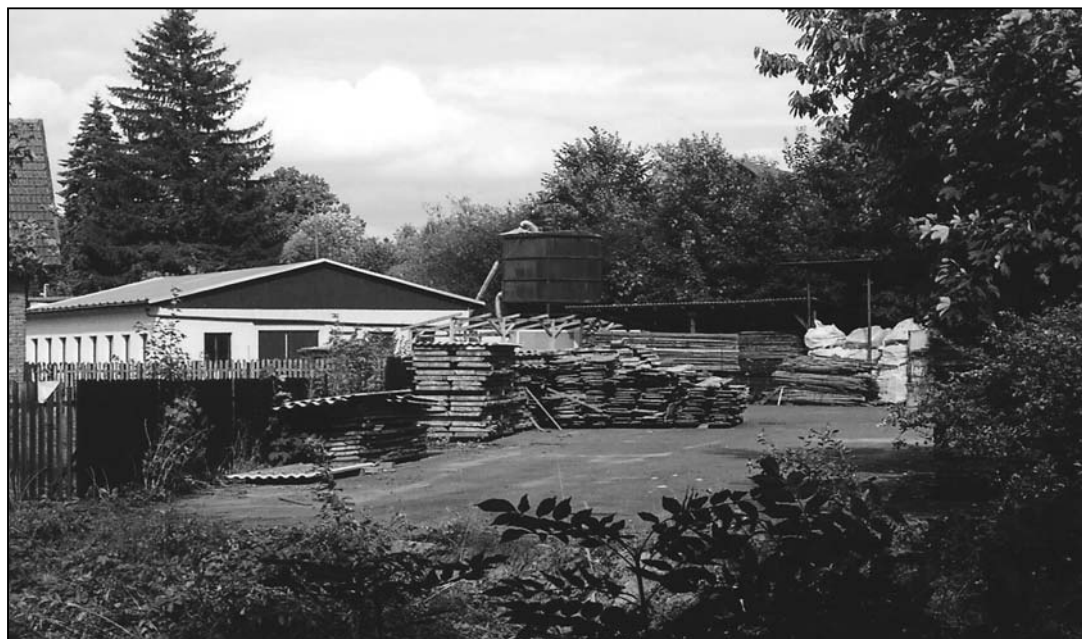
Obr. č. 3: Soukromý podnik na zpracování dřeva (bývalá pila) (Otradov)
