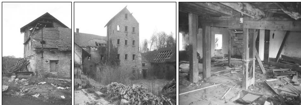
Obr. č. 8: Kožušice - Mlýn, stav v roce 2008 před celkovou demolicí
