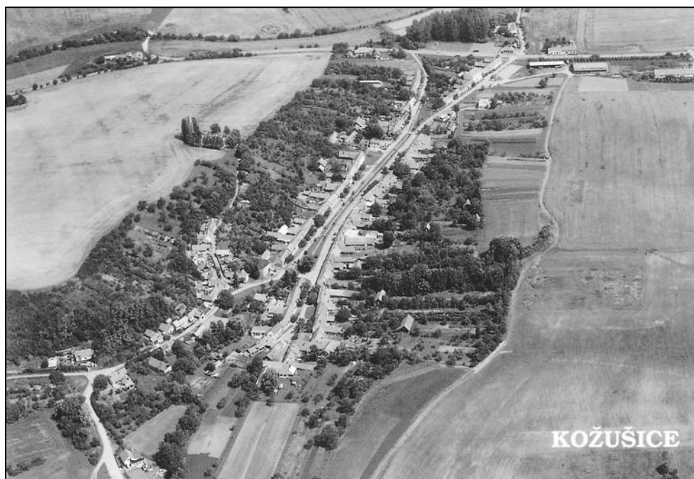
Obr. č. 2: Letecký pohled na Kožušice, pohlednice
