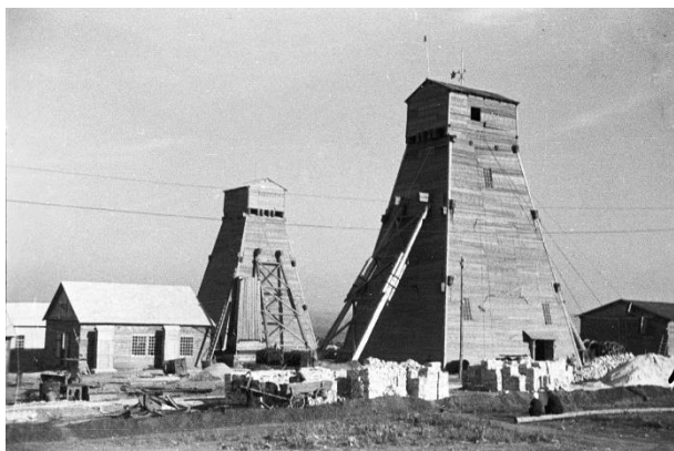
Рис. 26. Строительство новой шахты на Донбассе в годы НЭПа (УССР).
